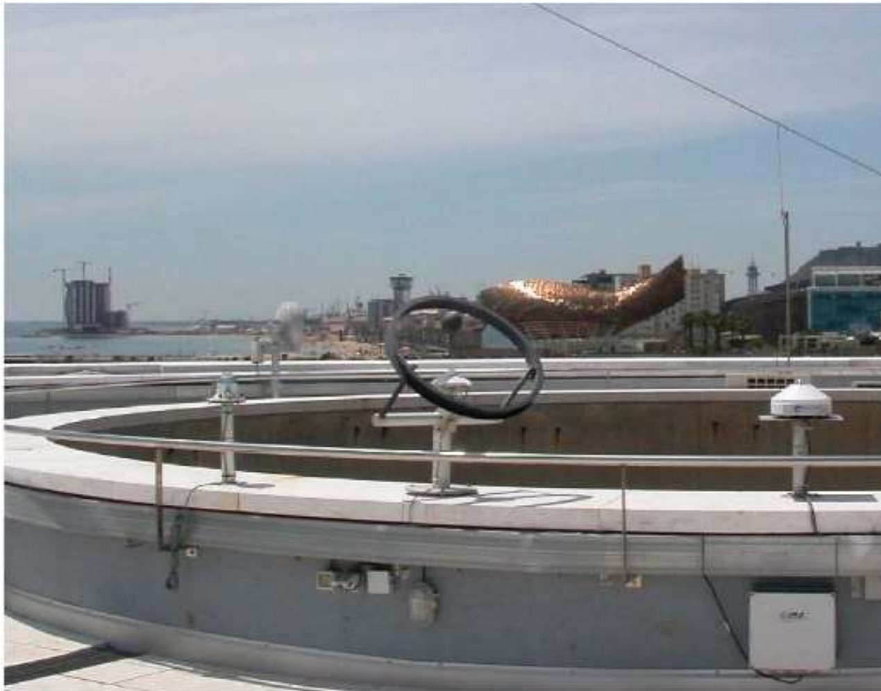
Estación radiométrica para medir radiación solar global difusa y ultravioleta
